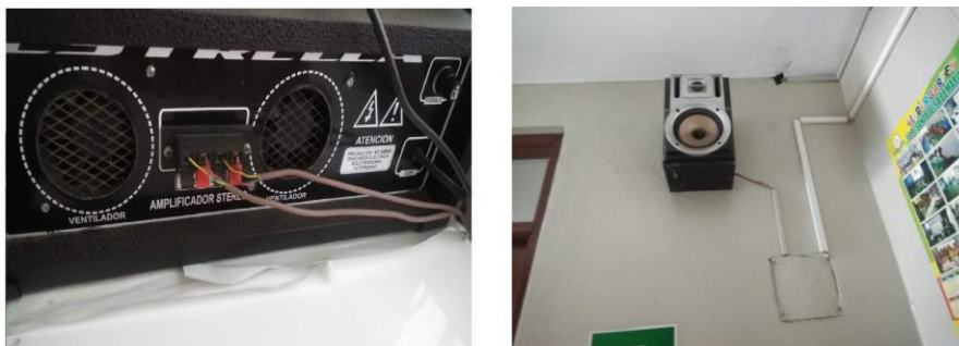
Figura 14: Cableado y conectividad del parlante y amplificador
