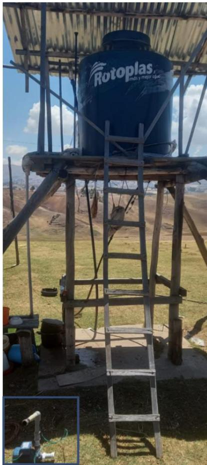
**Nota.** En la figura se observa motor Bomba de Agua Periférico 0.5 HP
