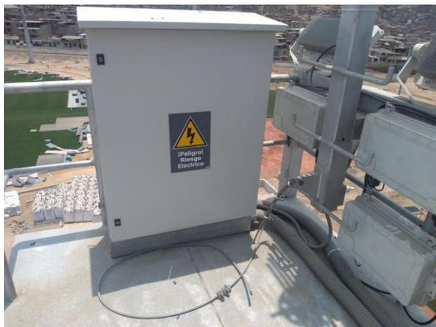
**Figura 8. Tablero de Energía en Postes**
