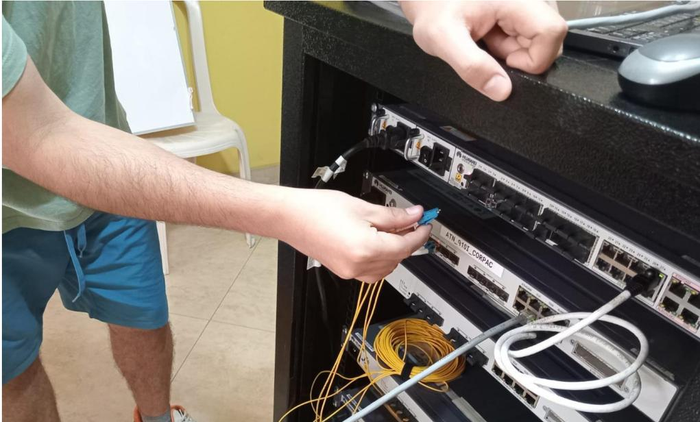
**Figura 48: Fibra desconectada del router principal**
