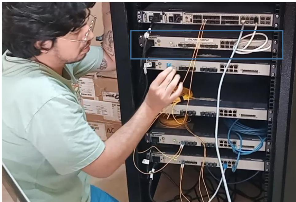
**Figura 52: Desconexión de enlace de respaldo**
