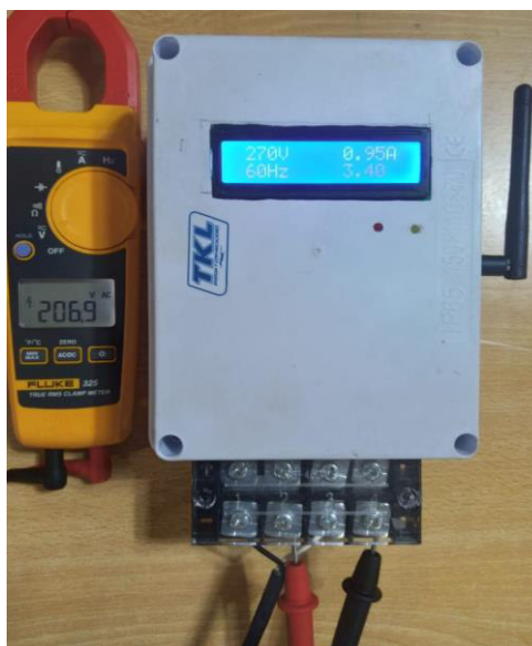
Figura 96. Fotografía de los parámetros de red obtenidos del medidor.
