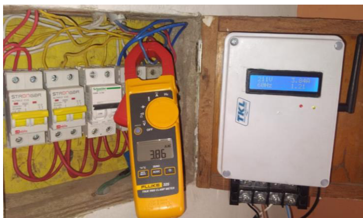
Figura 100. Calibración de la señal de corriente Fuente: Propia
