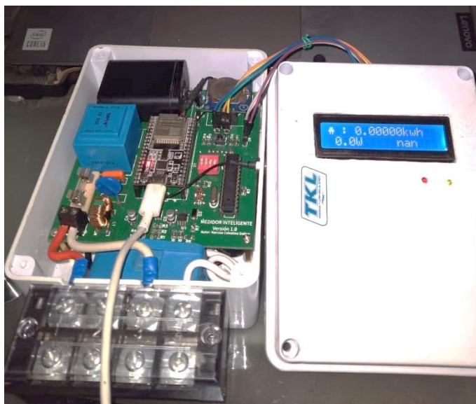
Figura 95. Acondicionamiento final y primer encendido del medidor
