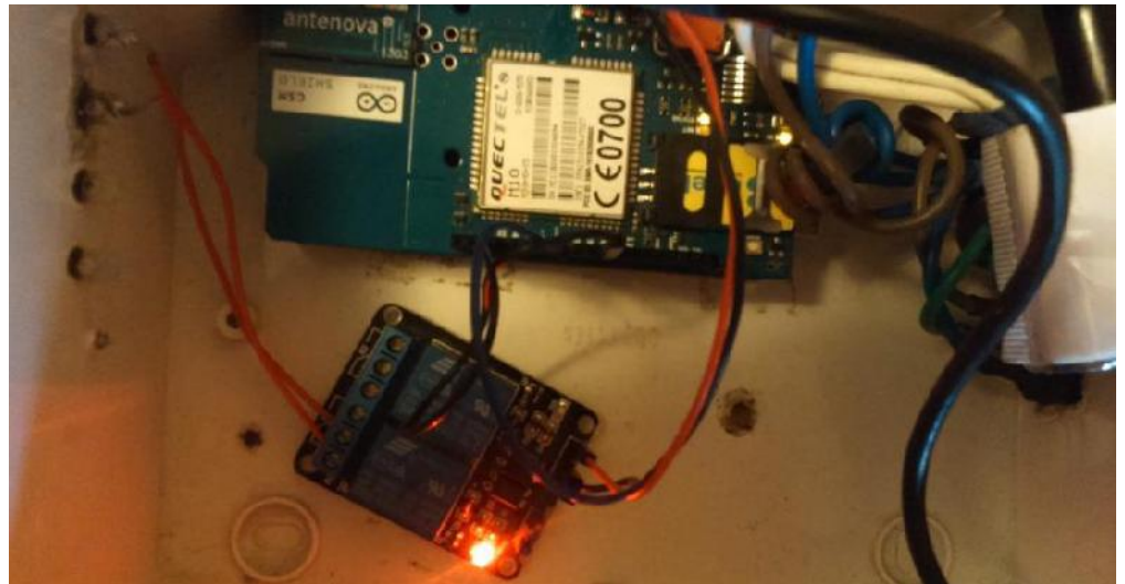
Figura 47. Interior del nodo Controller
